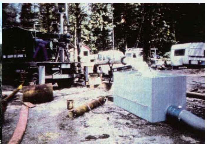
Ensayo de bombeo en Oizetxebarrieta-Abis a 90 l/s.
