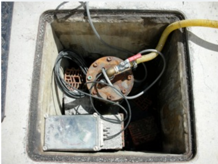
Detalle arqueta sondeo Tole
