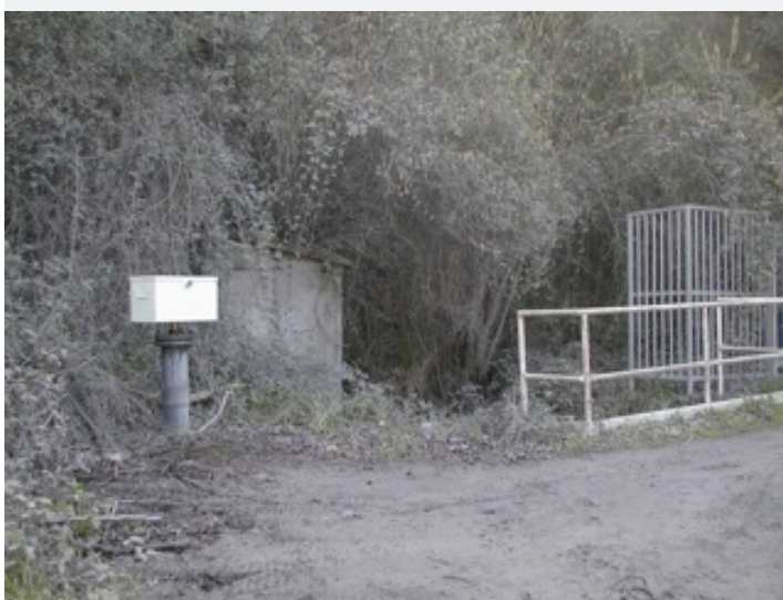
Situación sondeos Aguas Frías
